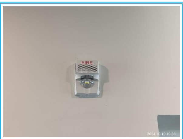
รูปที่ 3-32 สัญญาณแจ้งเหตุแบบกริ่ง
