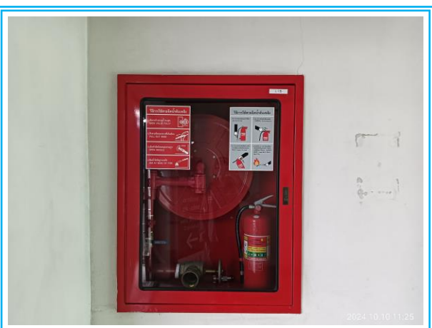
รูปที่ 3-35 ตู้เก็บสายฉีดน้ำดับเพลิง (Fire Hose Cabinet)
