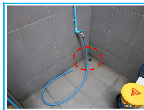
รูปที่ 3-27 ท่อรวบรวมน้ำจากการล้างถังมูลฝอย
