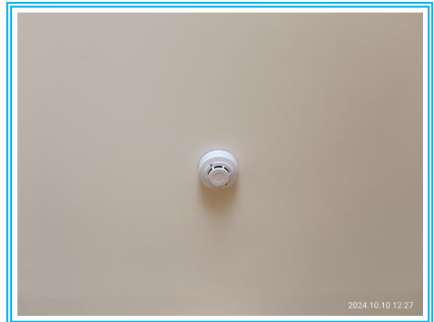
รูปที่ 2.9-2 Smoke Detector
