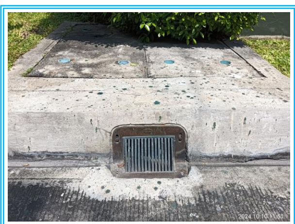
รูปที่ 3-19 ตะแกรงดักขยะบริเวณบ่อพักน้ำ
