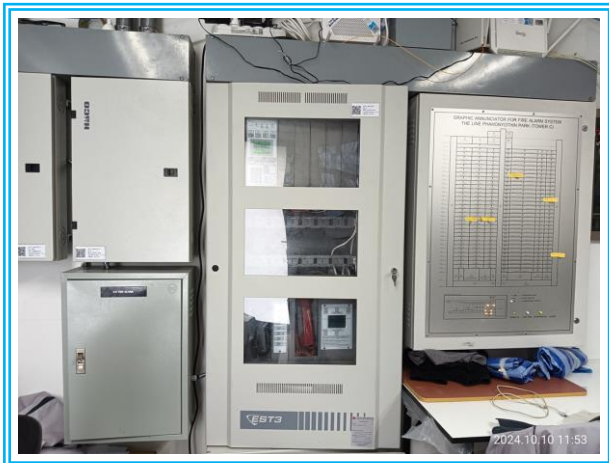
รูปที่ 2.9-1 Fire Alarm Control Panel
