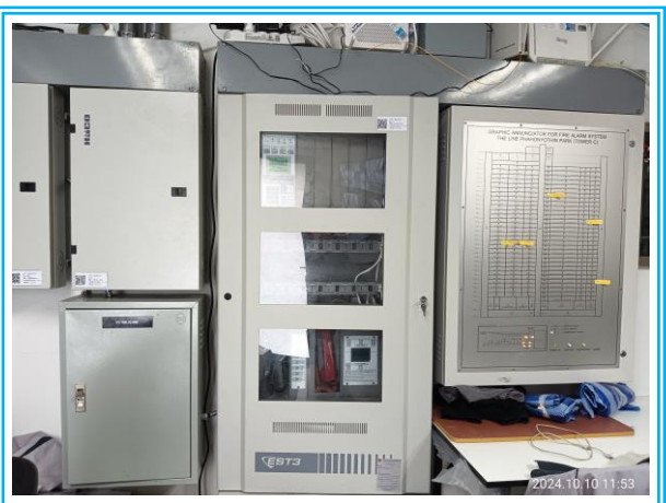
รูปที่ 3-28 แผงควบคุมระบบแจ้งเหตุอัคคีภัย (FCP)
