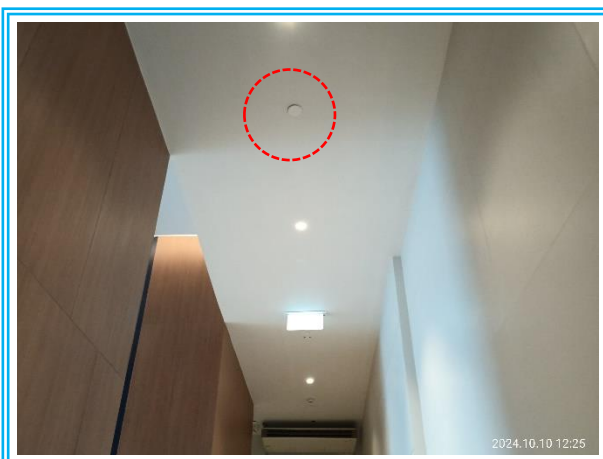
รูปที่ 3-30 เครื่องตรวจจับความร้อน (Heat Detector)
