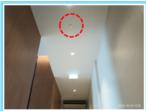
รูปที่ 2.9-3 Heat Detector
